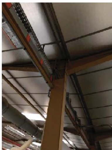
Encastrement tête de poteaux
